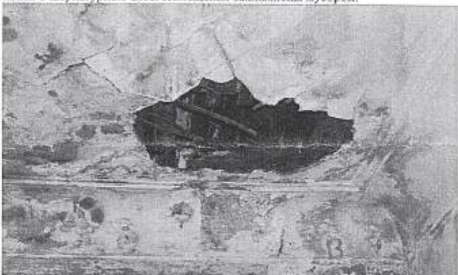
Фото 6 от 24.11.2015. В помещениях зафиксированы разрушения перекрытий и декоративных элементов: следы намокания, отпадение большими массивами штукатурного слоя до оголения дроби, поражение деревянных конструкций перекрытий гнилью, нарушение целостности конструкции перекрытий, сквозные отверстия (обрушения перекрытий).
