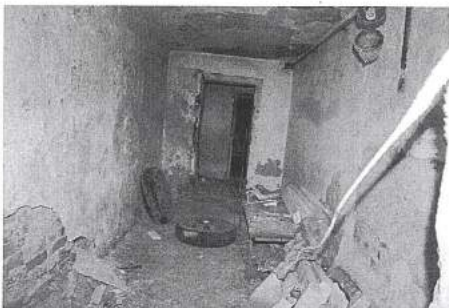
Фото 5 от 24.11.2015. Фрагмент подвального помещения – обрушение и трещины в штукатурном слое. Помещения захлаплены мусором.
