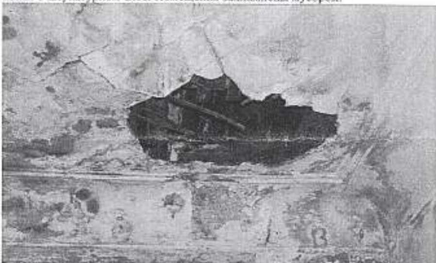
Фото 6 от 24.11.2015. В помещениях зафиксированы разрушения перекрытий и декоративных элементов: следы намокания, отпадение большими массивами штукатурного слоя до оголения дроти, поражение деревянных конструкций перекрытий гнилью, нарушение целостности конструкции перекрытий, сквозные отверстия (обрушения перекрытий).
